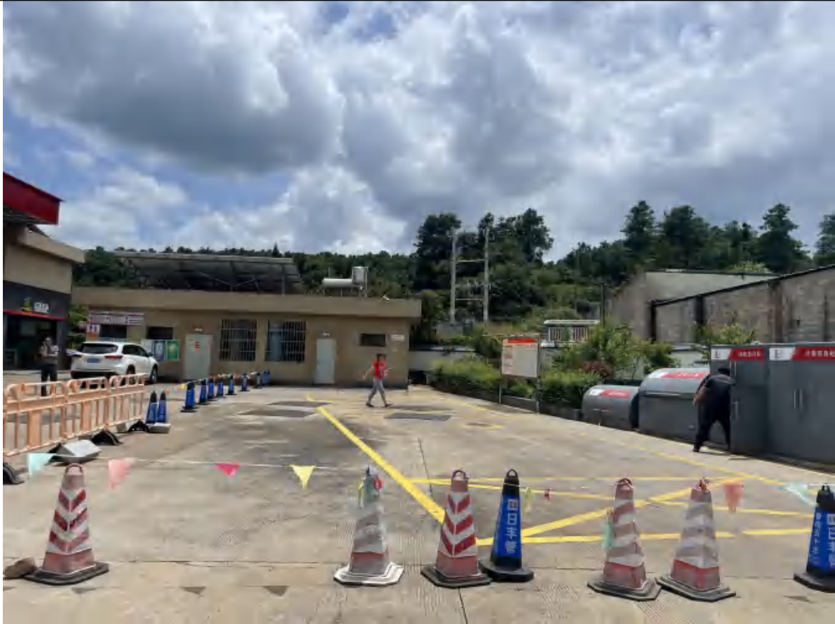
图 3 加油站储罐区
